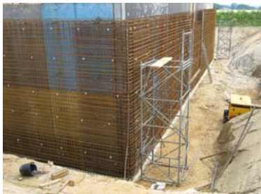
Bild 4: Bewehrung der Wände des Belebungsbeckens
