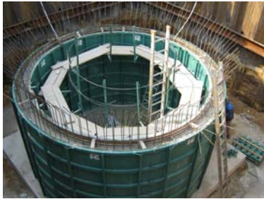
Bild 2: Bau des Nachklärbeckens
