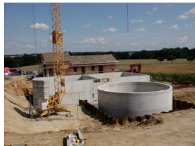
Bild 5: Übersicht Bau KA Dahlen
