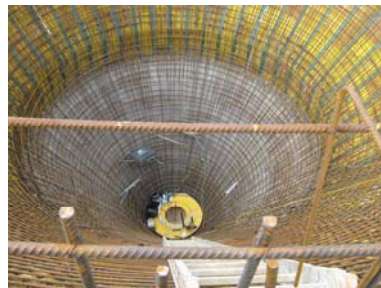
Bild 3: Bau des Trichters
